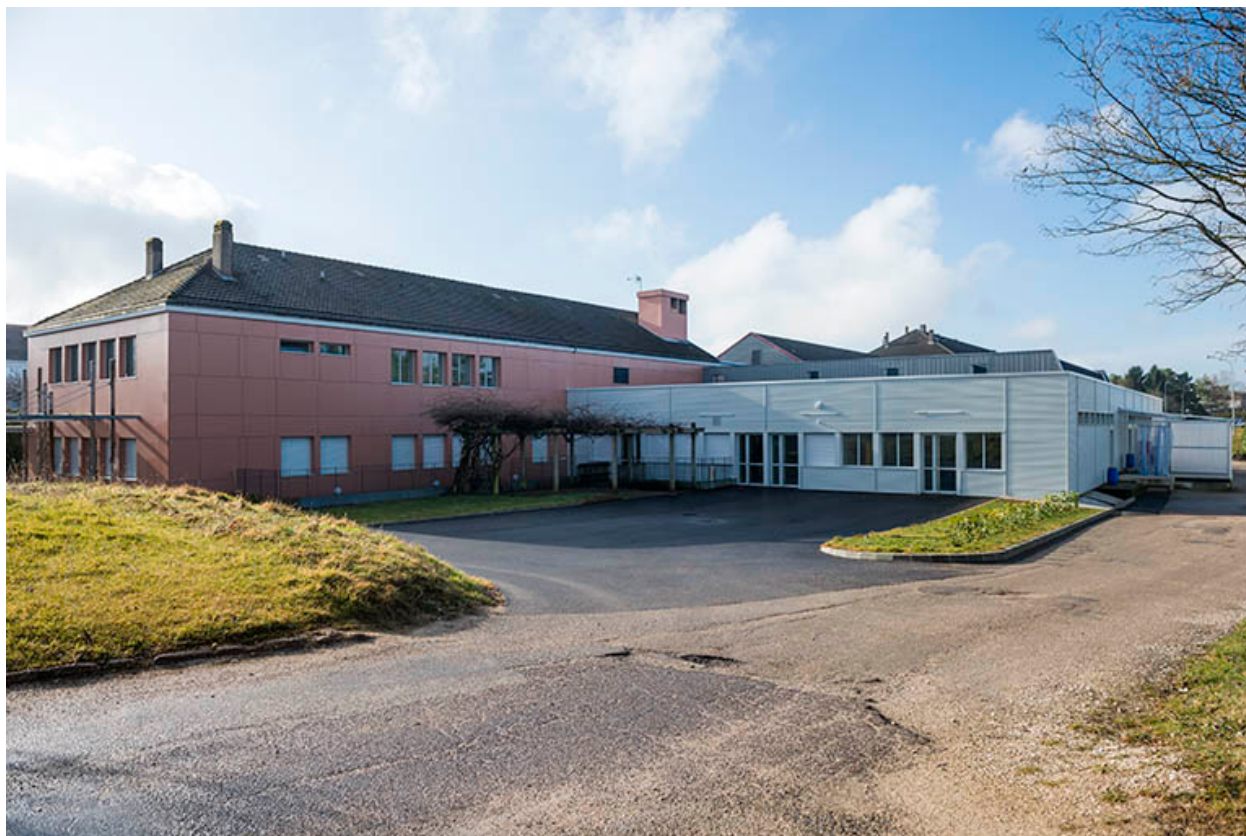
Vue de trois-quart des services communs.
