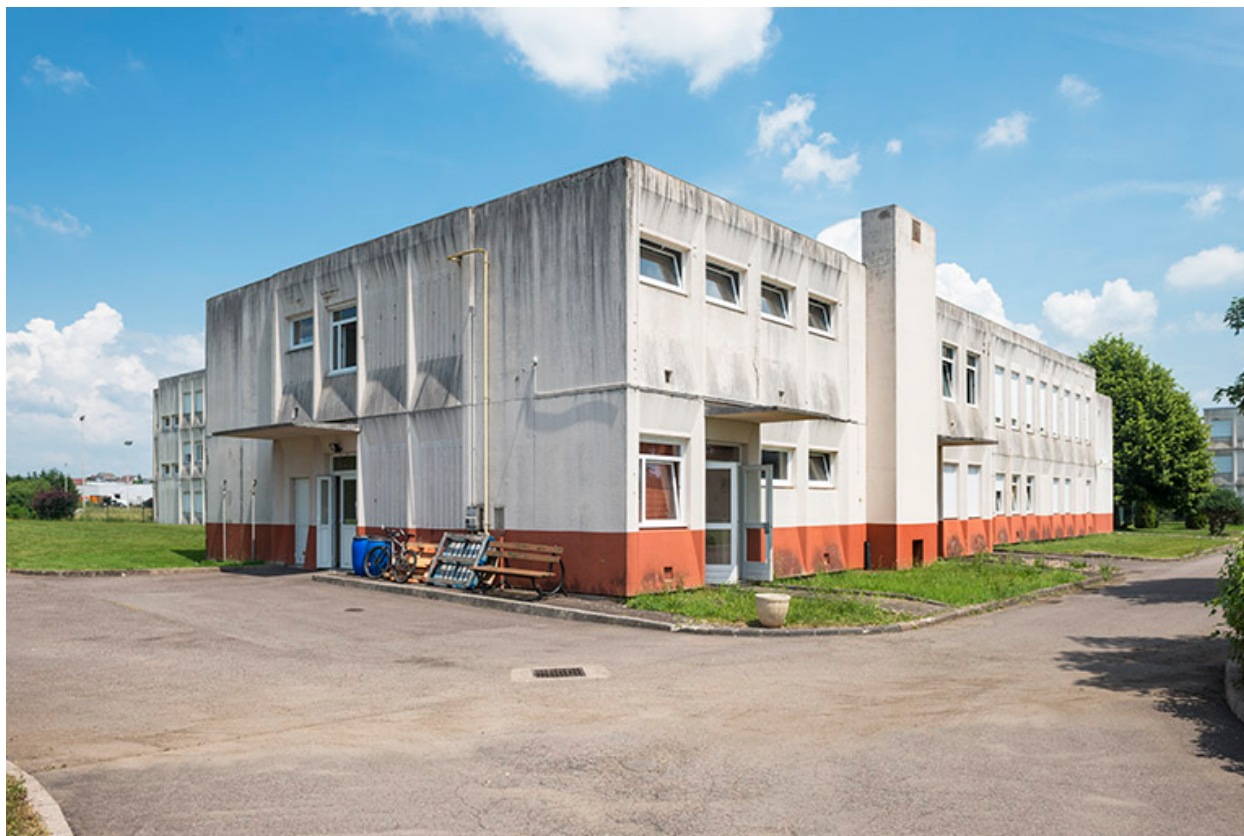
Angle sud-ouest de la restauration.
