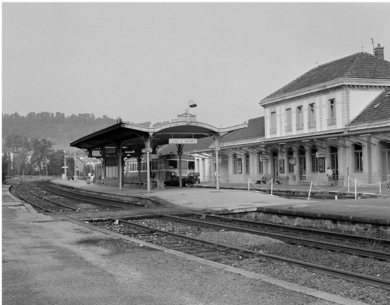
Façade postérieure et abri sur le quai.
