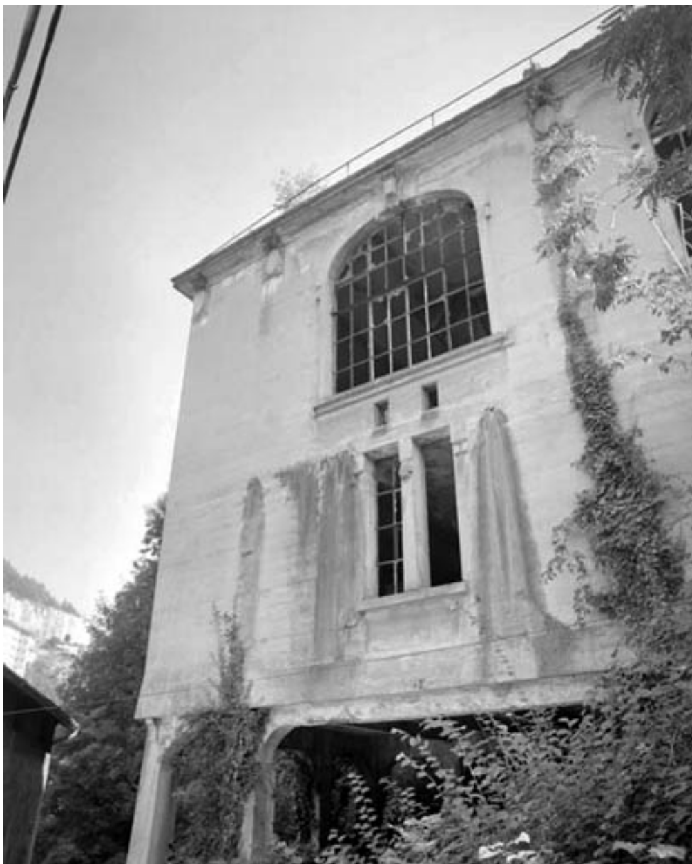
Façade latérale gauche du transformateur : une travée.
