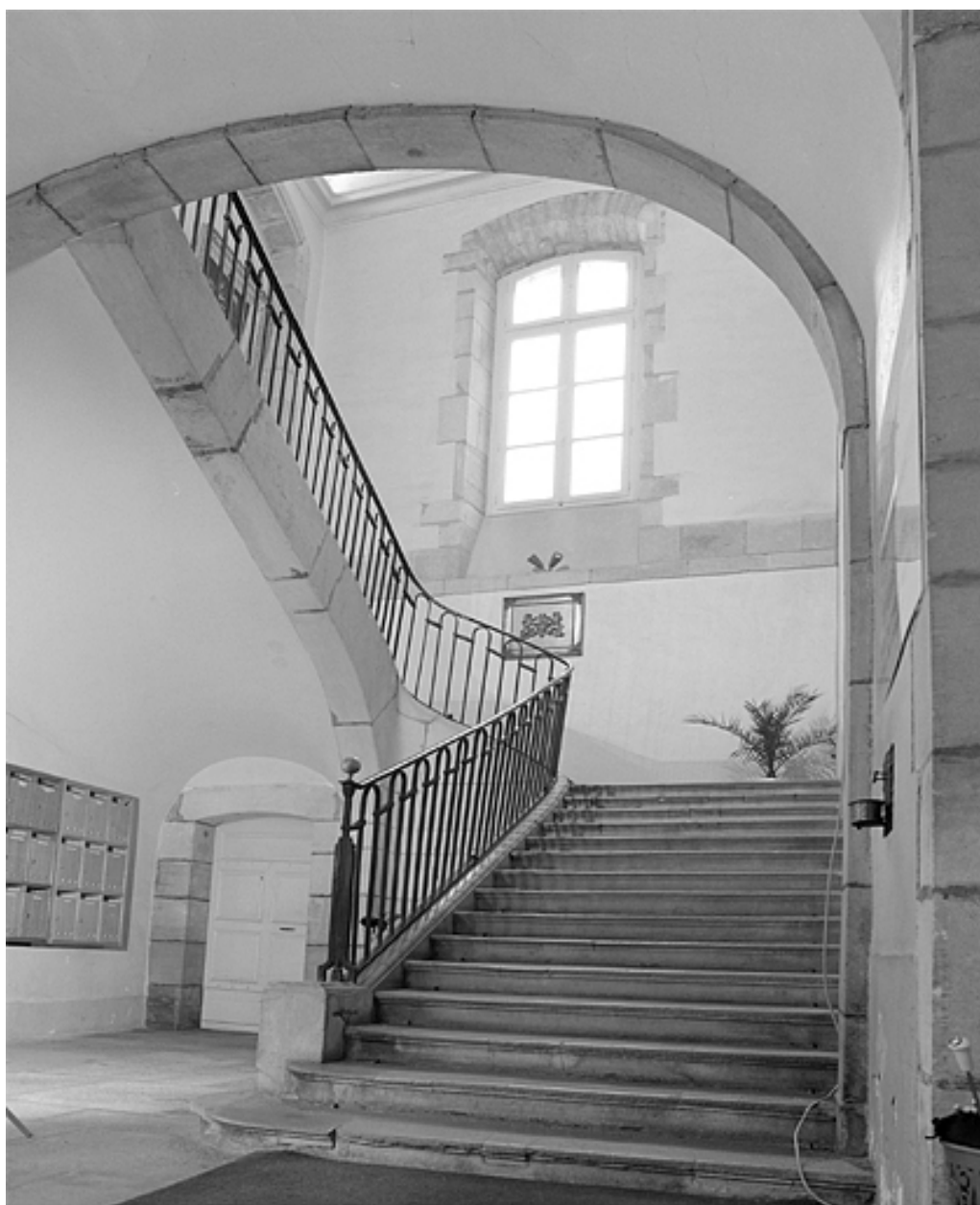
Grand escalier : vue générale.
