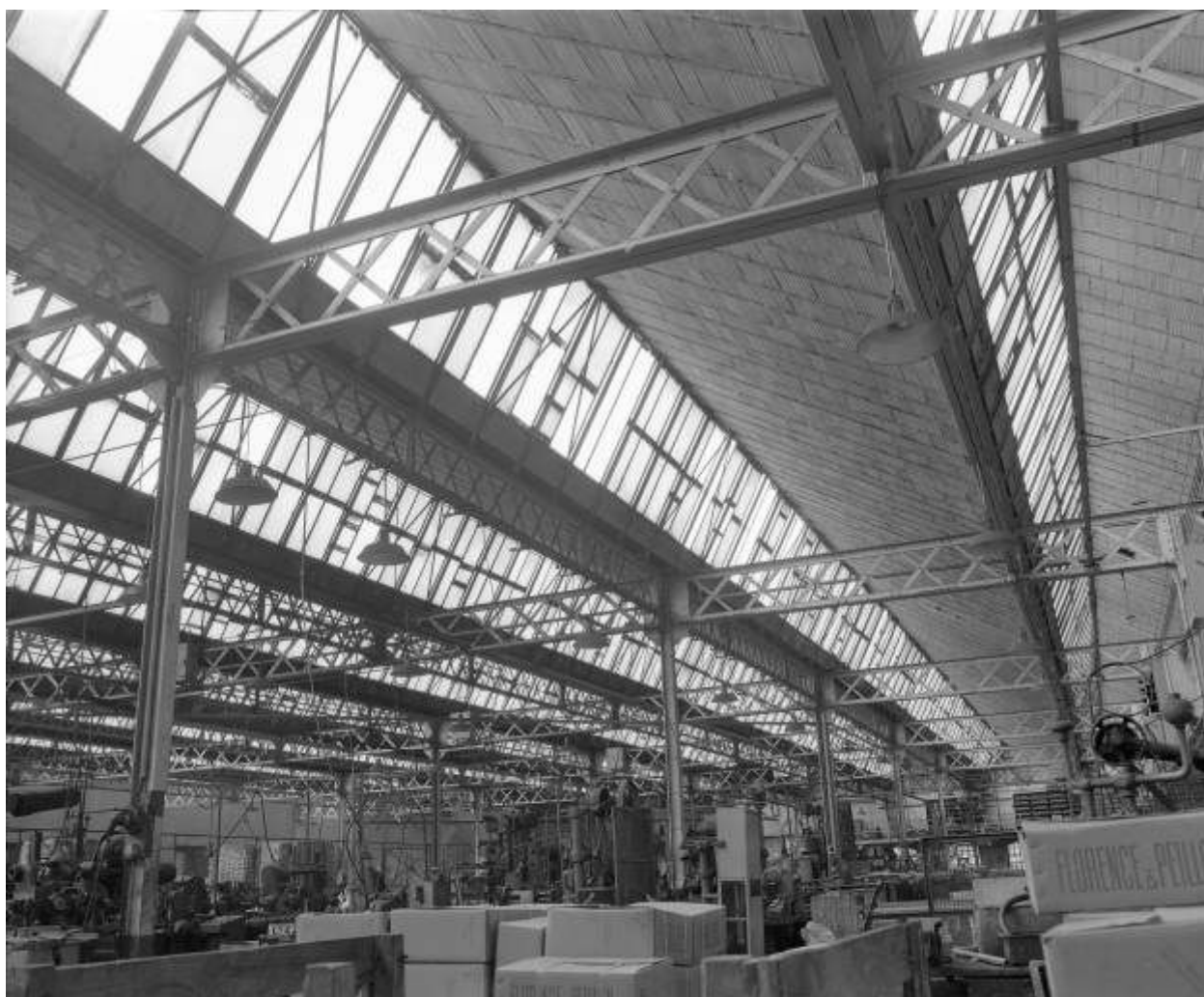
Vue intérieure de l'atelier des pompes en 1981.
