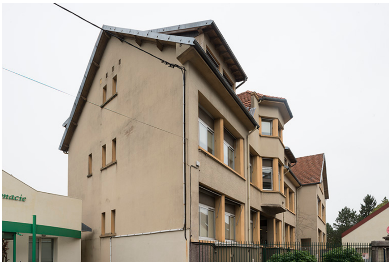
Bâtiment d'entrée vu de trois quarts.
