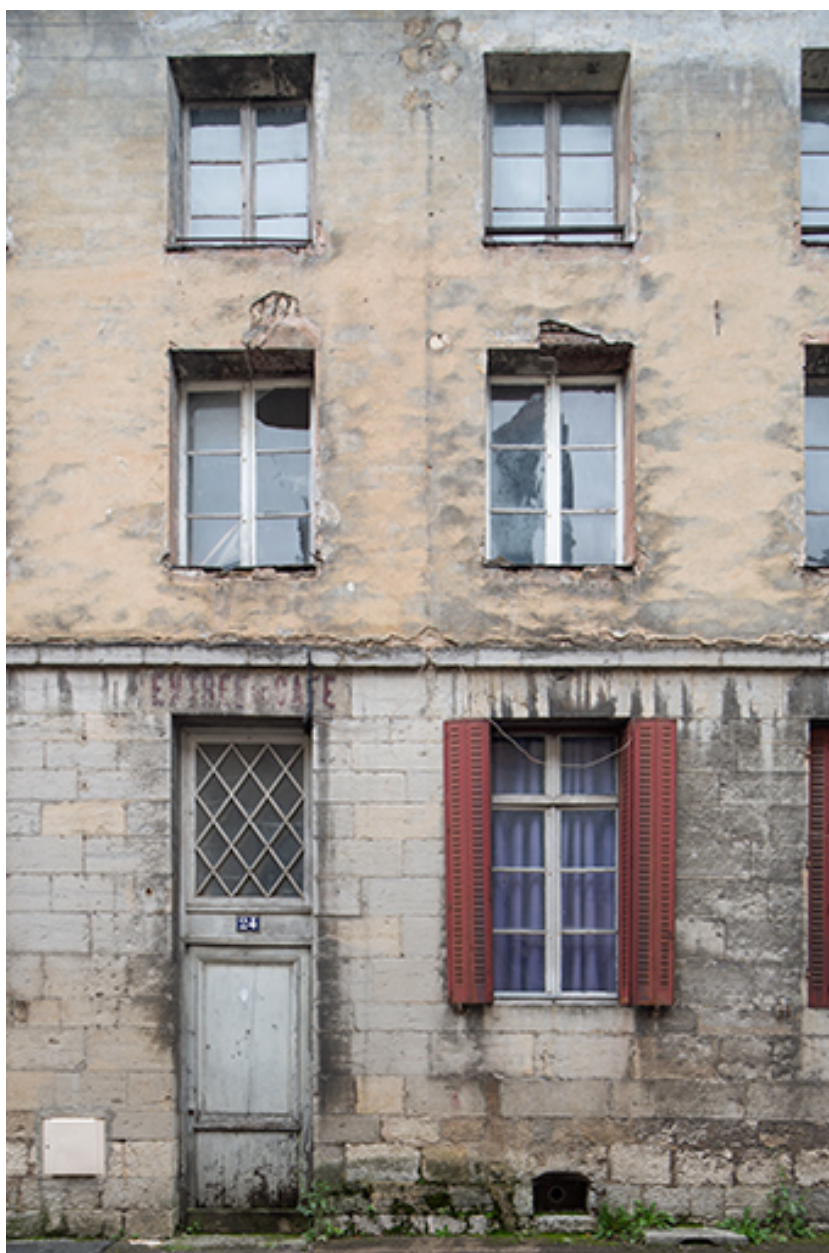
Travées centrales de la façade postérieure.
