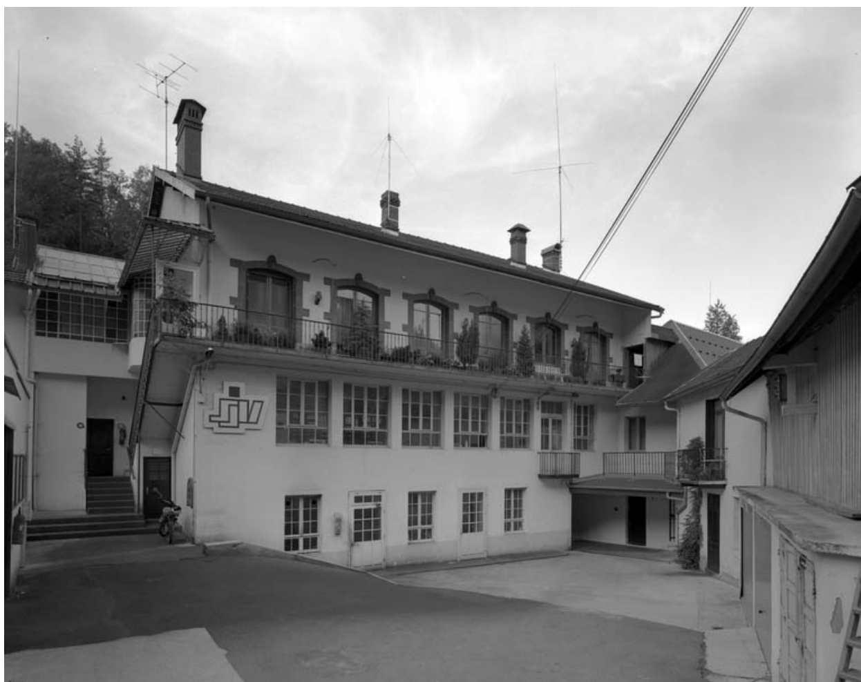
Façade sur cour du bâtiment de 1902.
