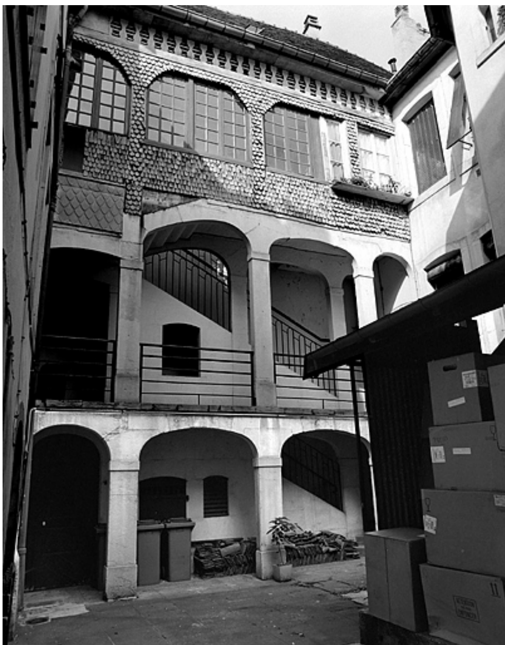
Escalier dans la cour, vue d'ensemble.
