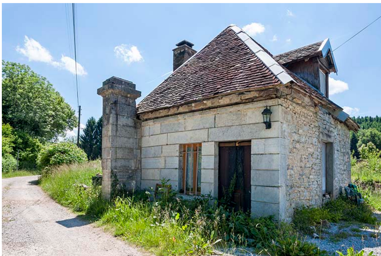
Pavillon d'entrée vu de trois quarts.
