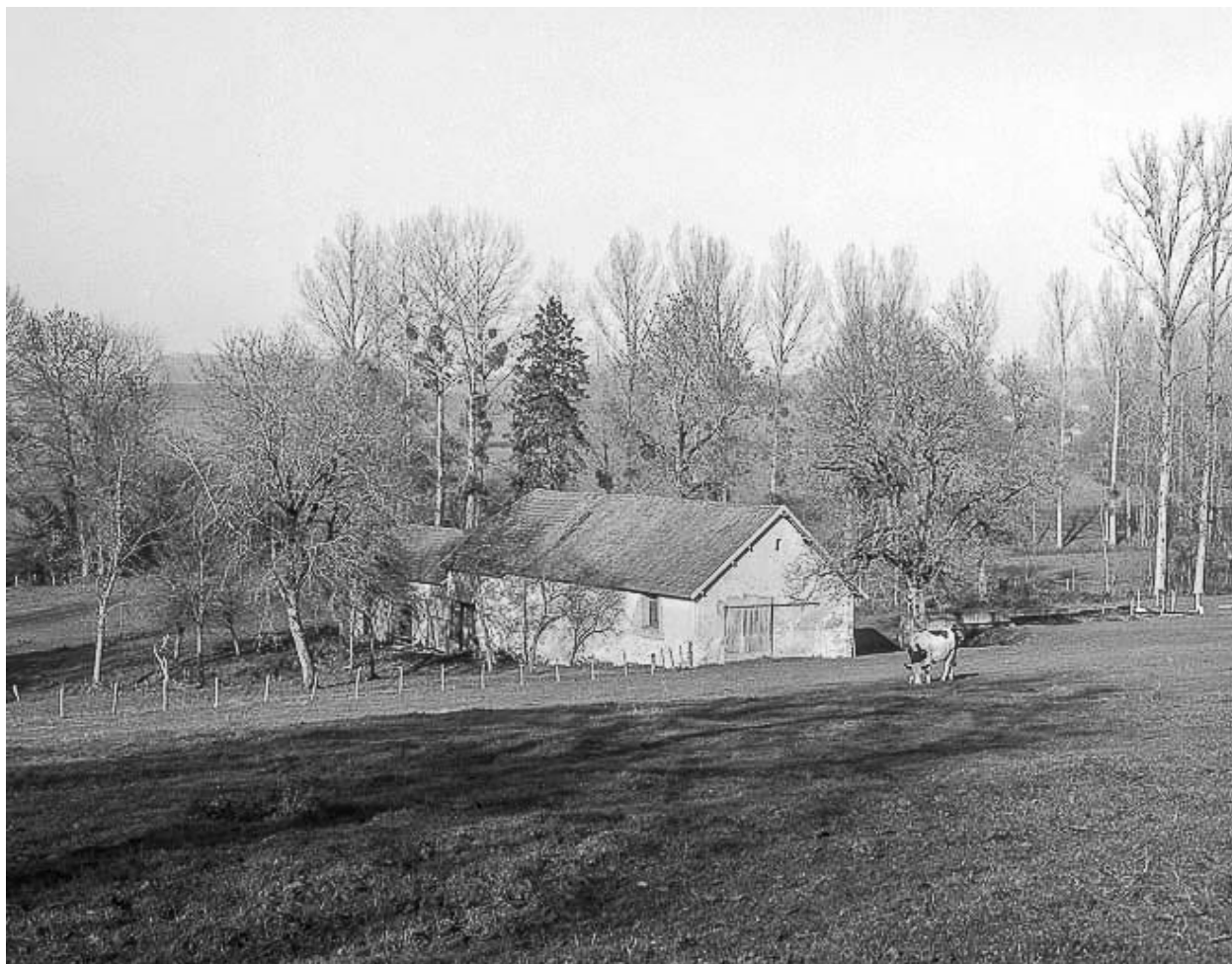
Vue d'ensemble éloignée du revers des bâtiments.
