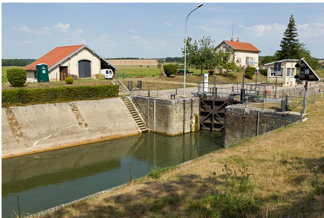
Entrée de l'écluse à sas.
