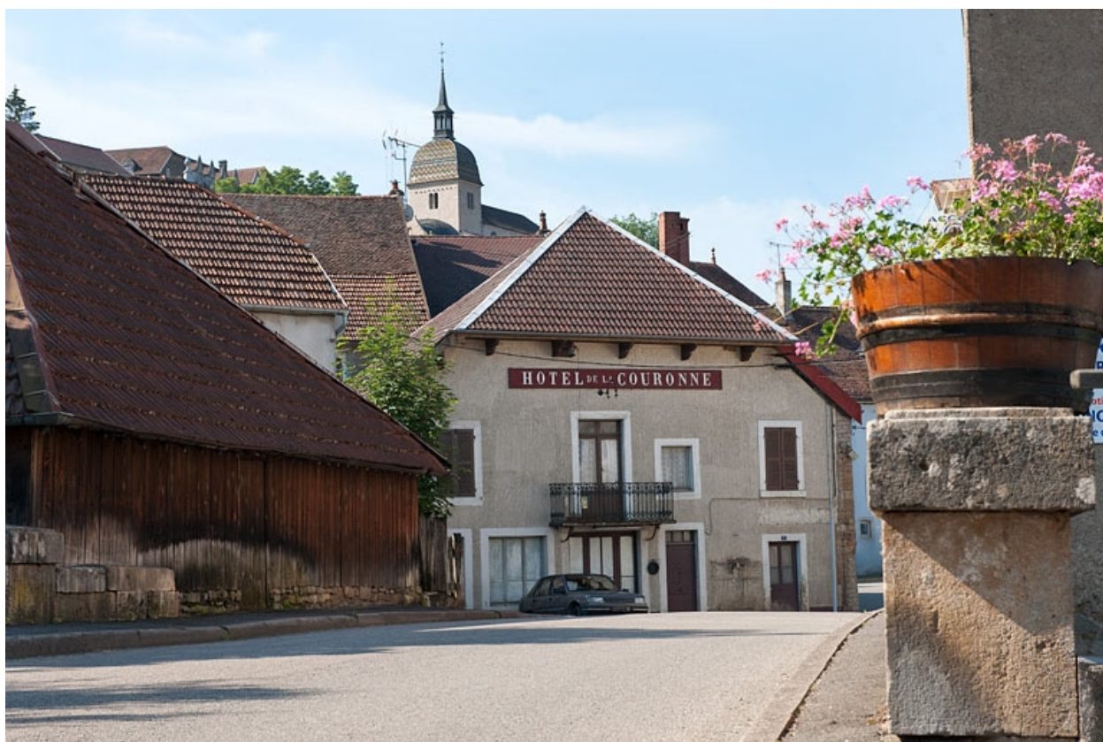
Vue générale éloignée.
