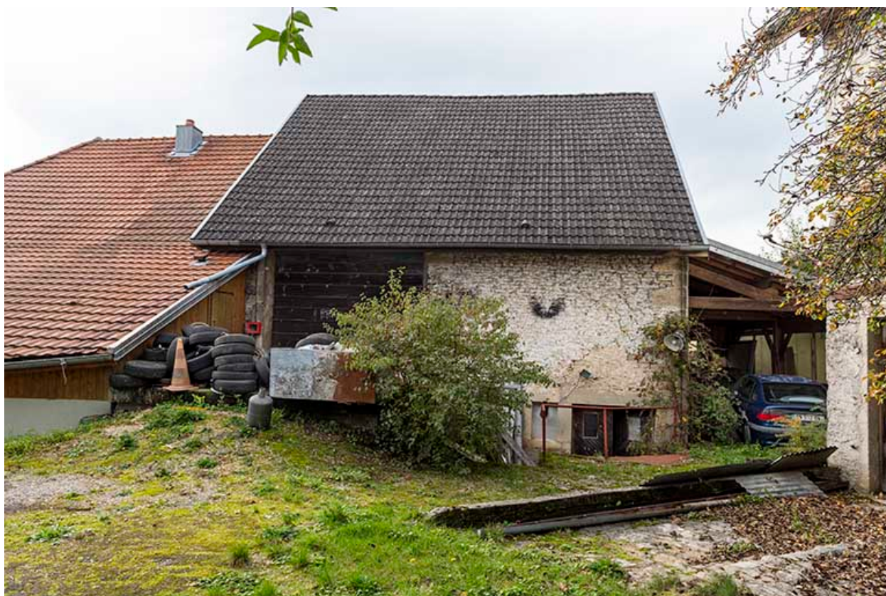
Façade latérale droite : la grange.
