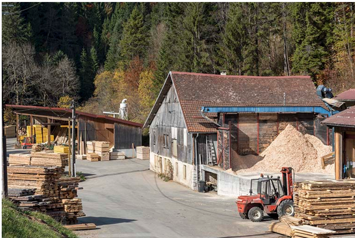
Ancienne scierie et ateliers à l'ouest.
