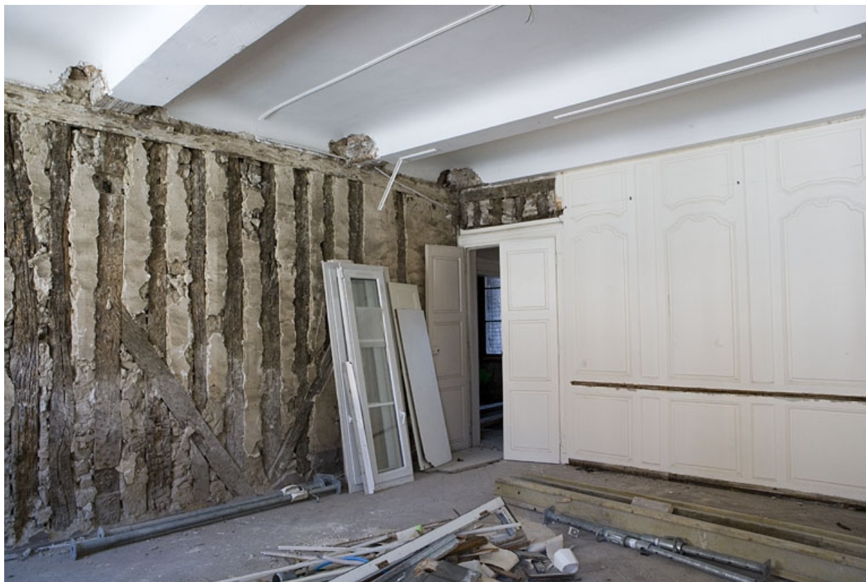
Intérieur, premier étage : détail d'un mur d'une pièce avec les lambris déposés.
