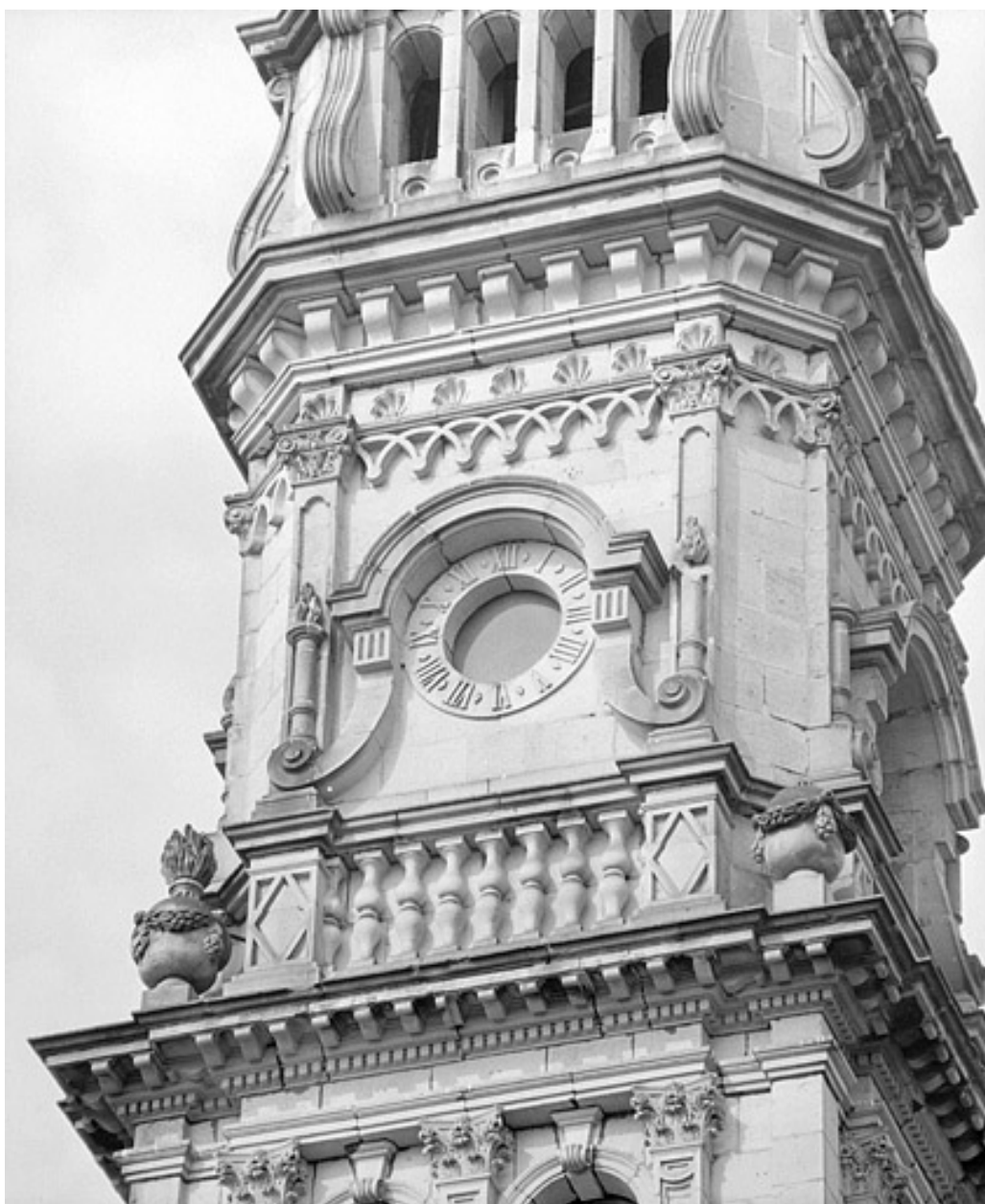
Quatrième niveau de la tour nord.
