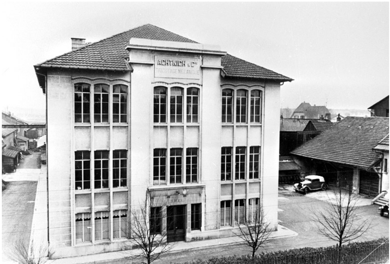
Façade nord de l'usine.
