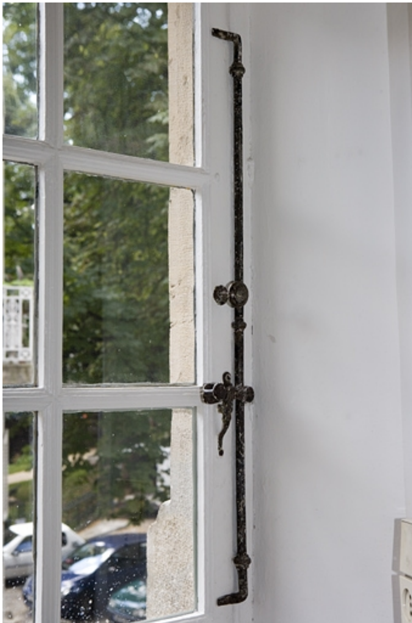
Intérieur, premier étage : détail d'une serrurerie de fenêtre, pièce à droite de l'escalier d'honneur.
