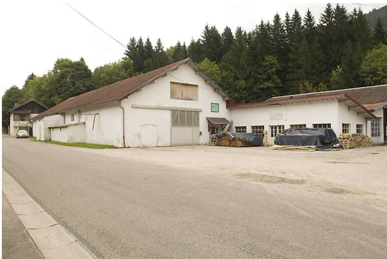
Partie nord du site : vue générale.
