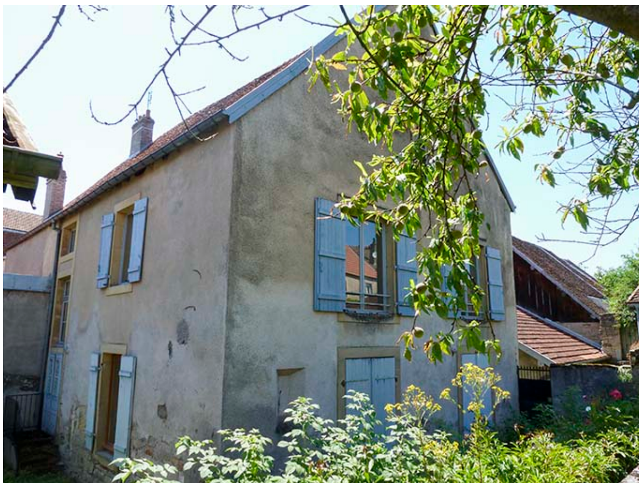
Façades postérieure et latérale droite.
