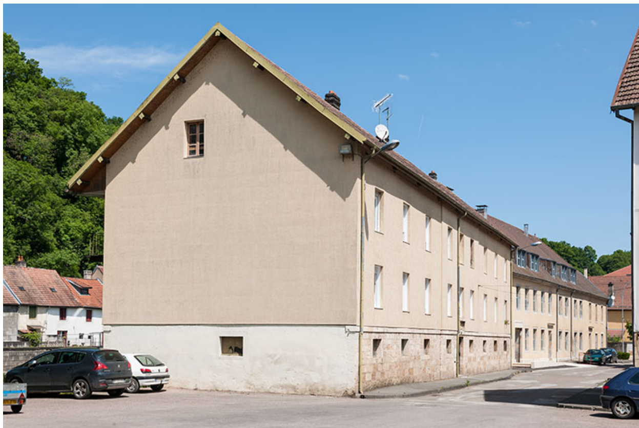
Logement occidental. Vue depuis le sud.
