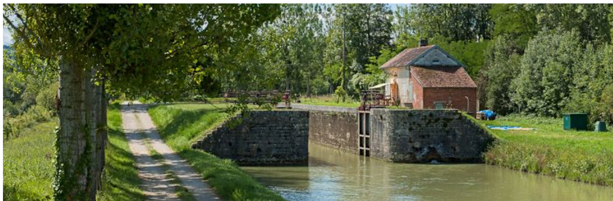
Vue du site d'écluse depuis l'aval.
