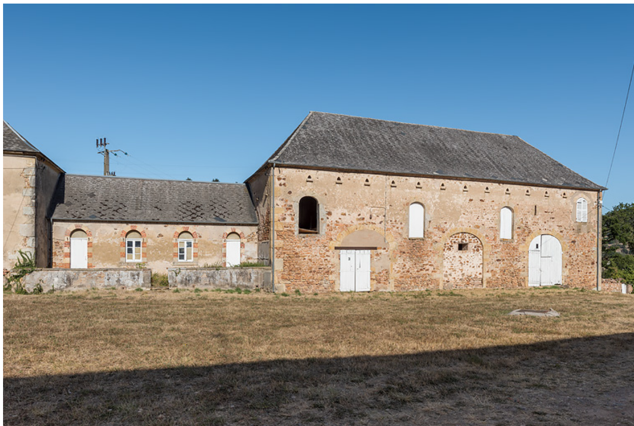
Bâtiment des dépendances.
