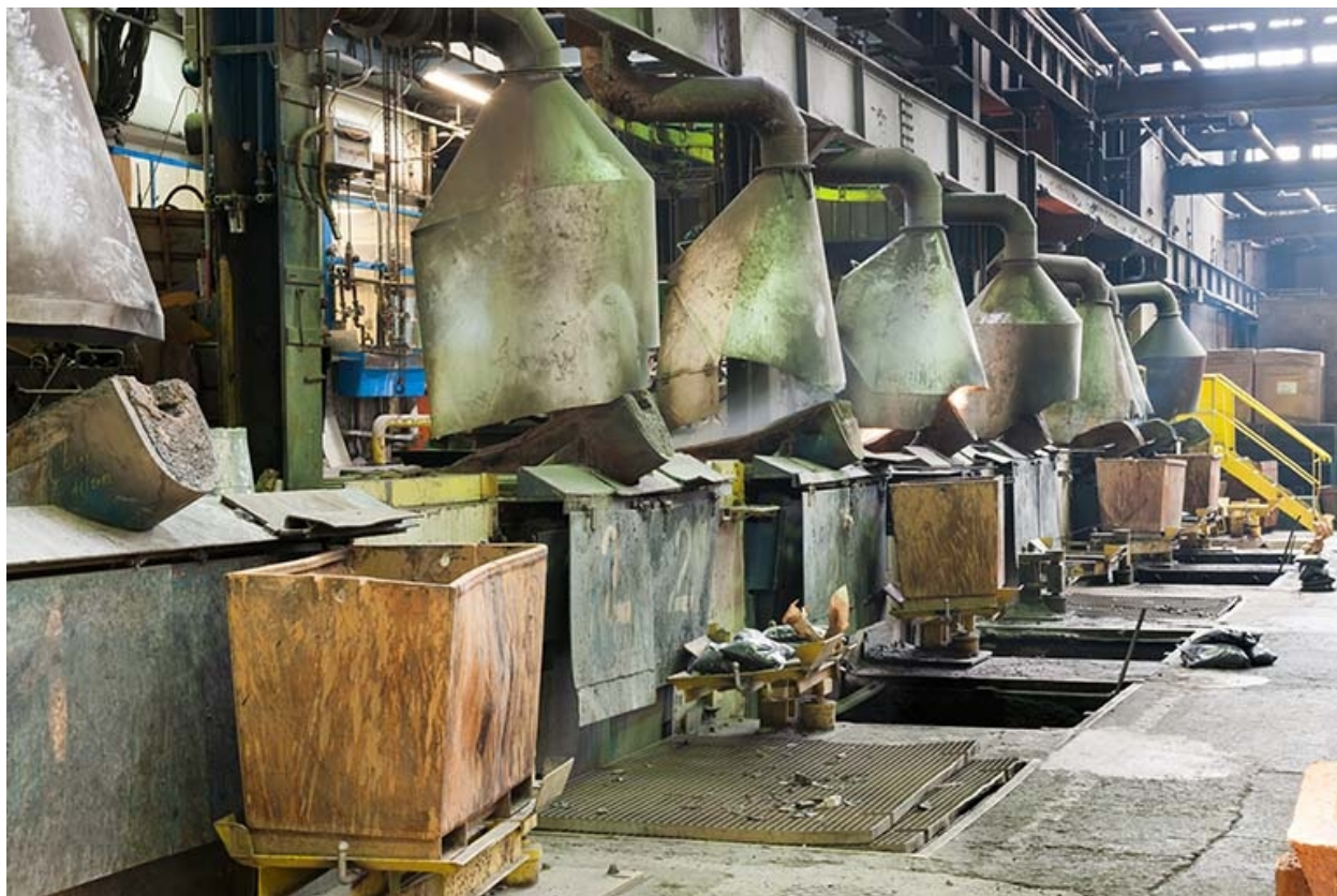
Batterie de fours à induction (1).
