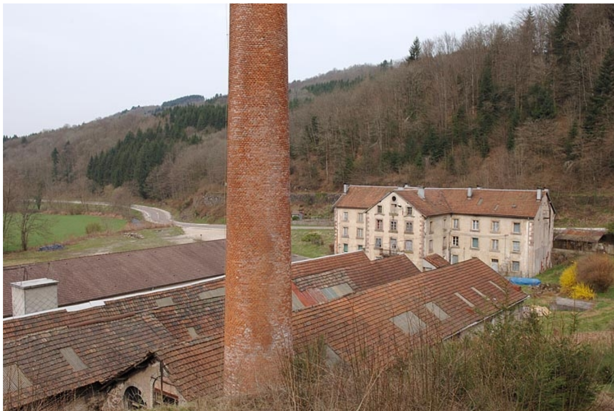
Vue plongeante depuis le nord-est.
