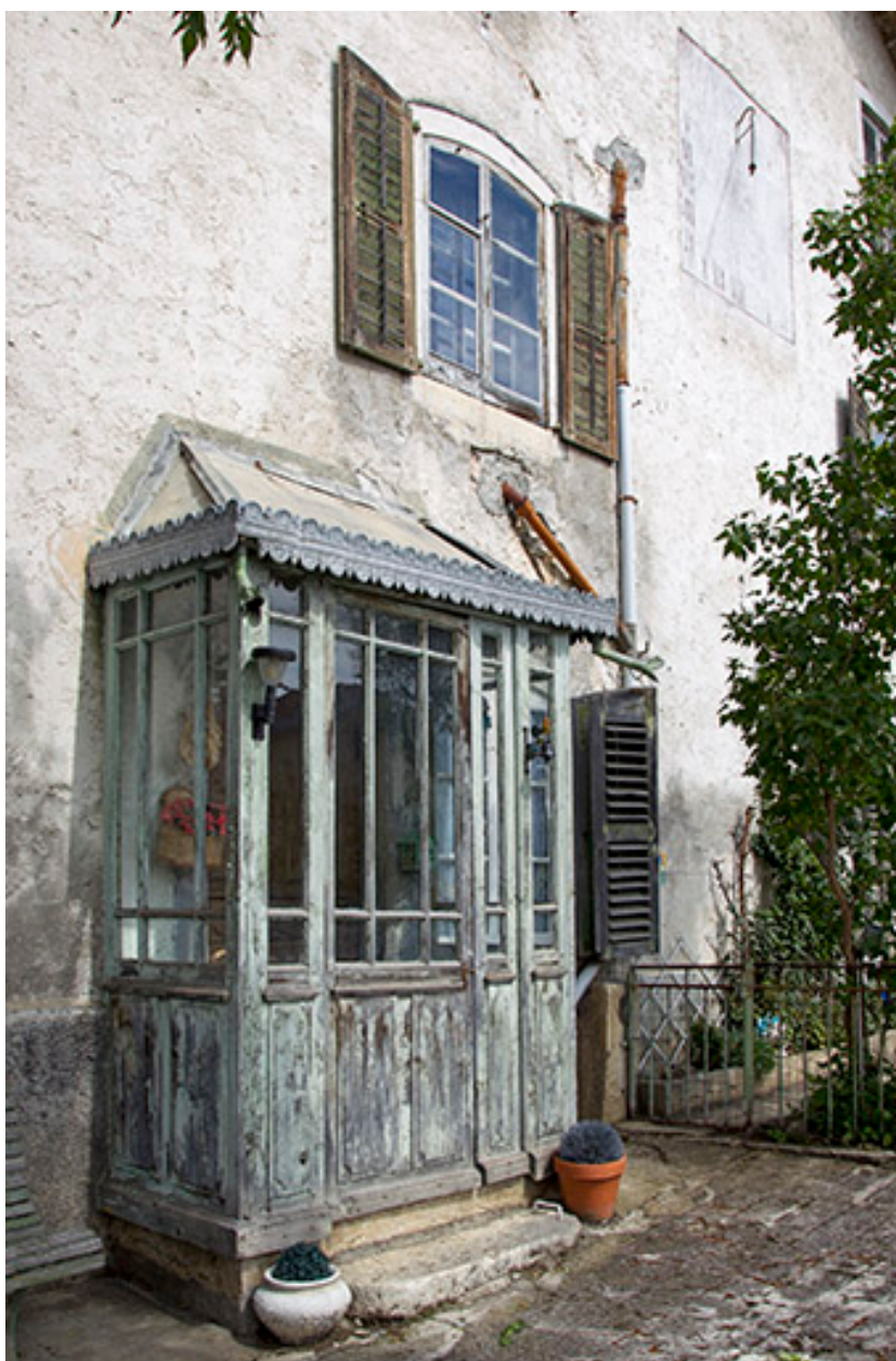
Façade antérieure : véranda, de trois quarts gauche.
