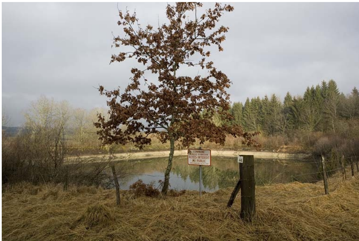
Réservoir, Pâturage de Montsevely : vue d'ensemble.
