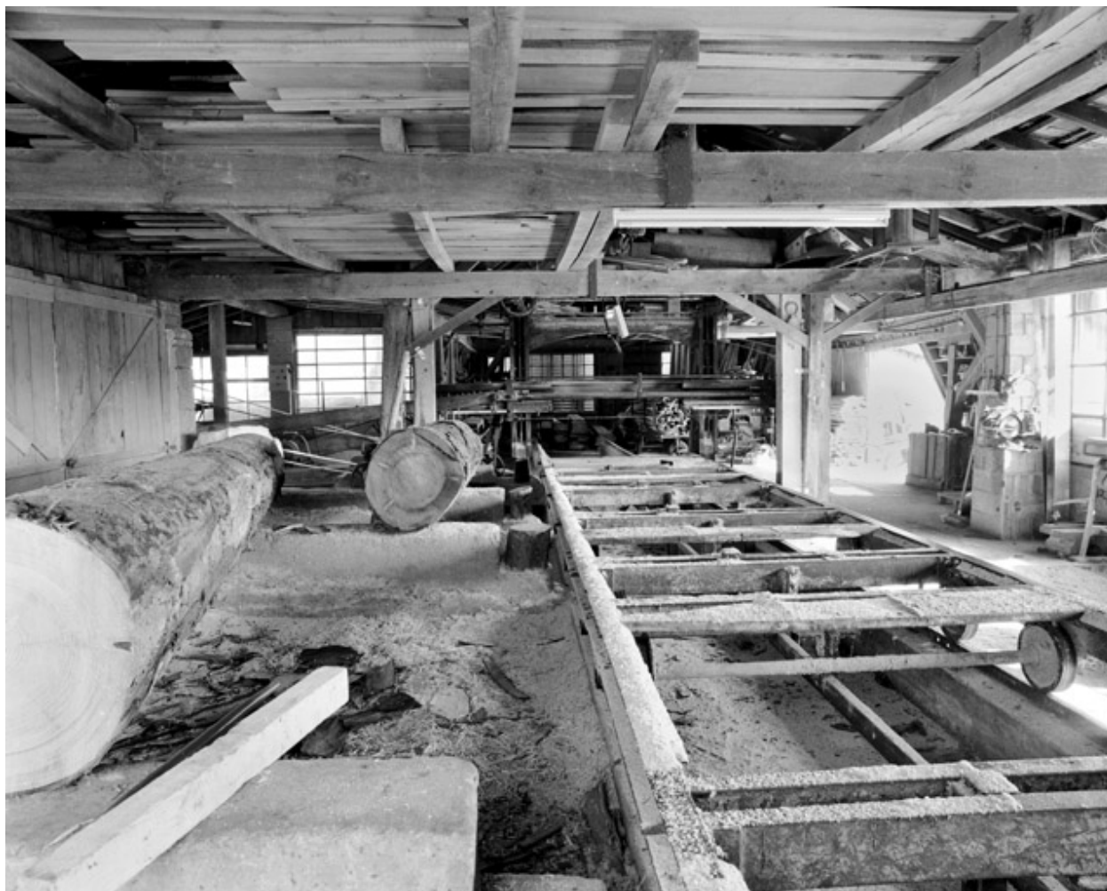
Chariot du châssis de scie.
