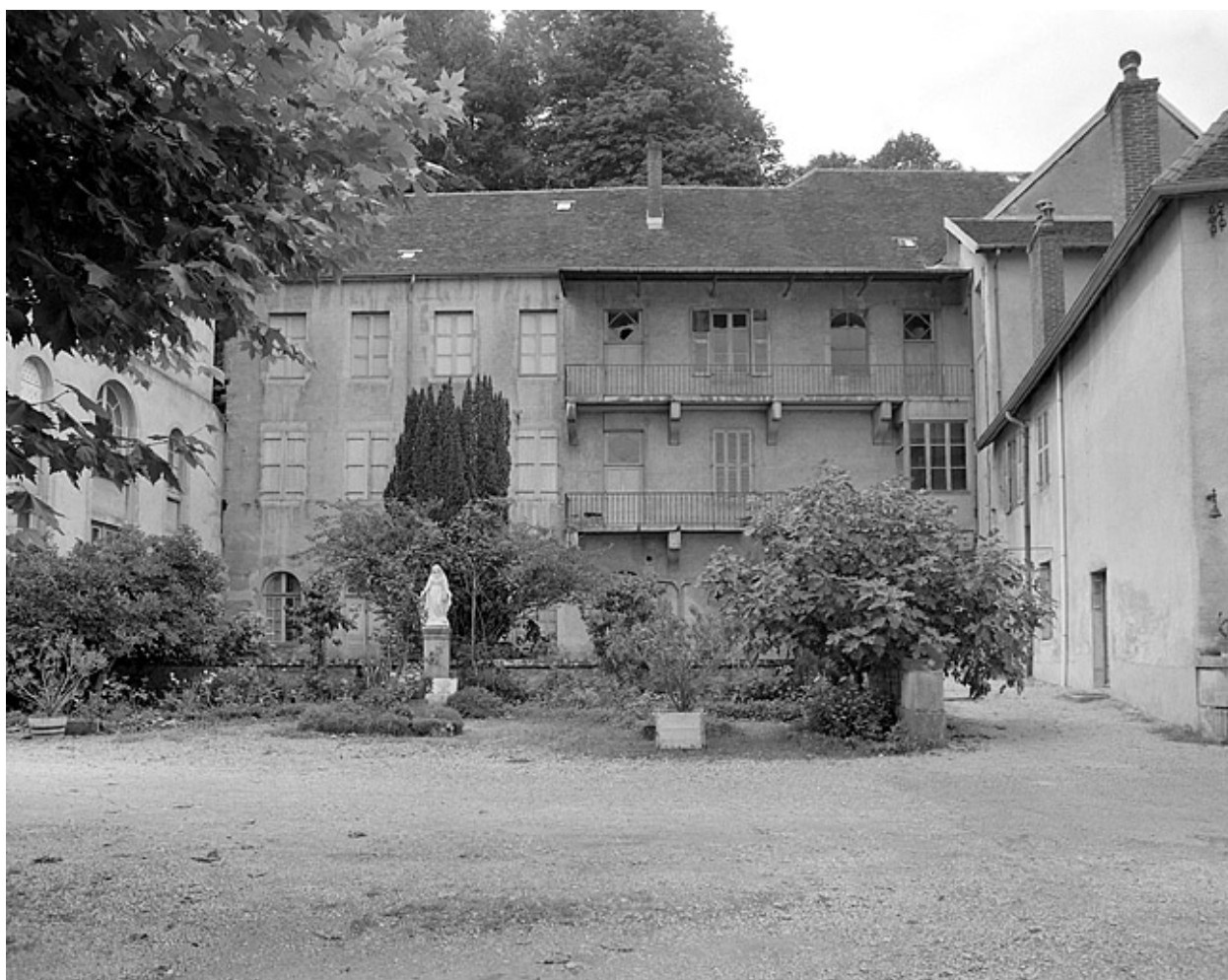
Façade latérale du bâtiment B.
