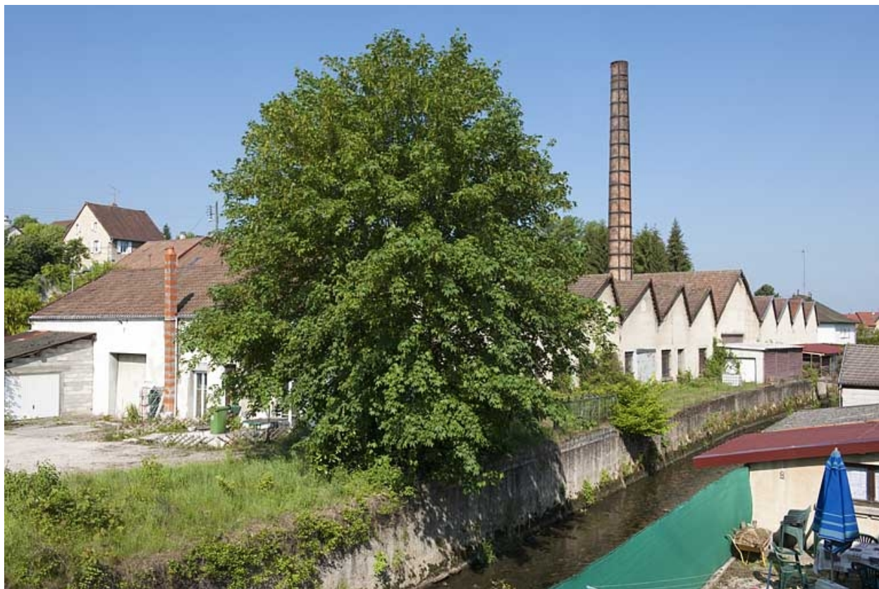
Atelier de laitonnerie. Vue depuis le sud-est.
