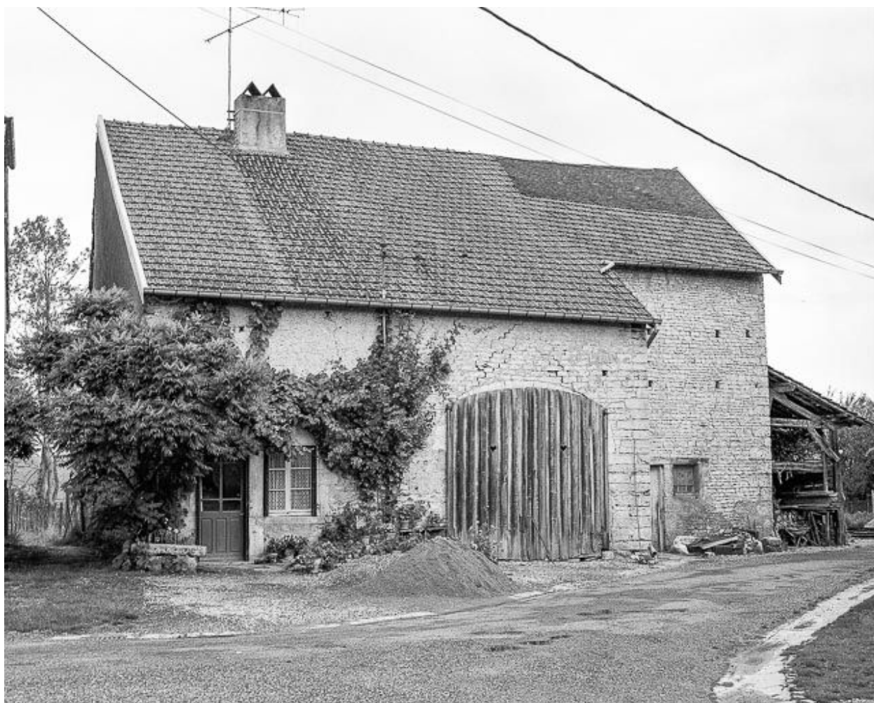
Ferme située 2 rue de la Riotte.
