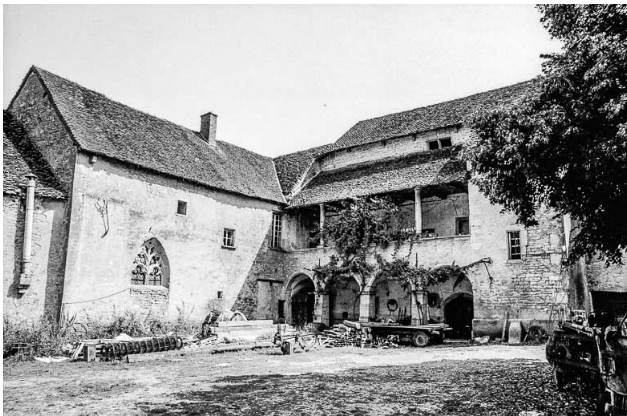
Galerie du corps de logis et chapelle.
