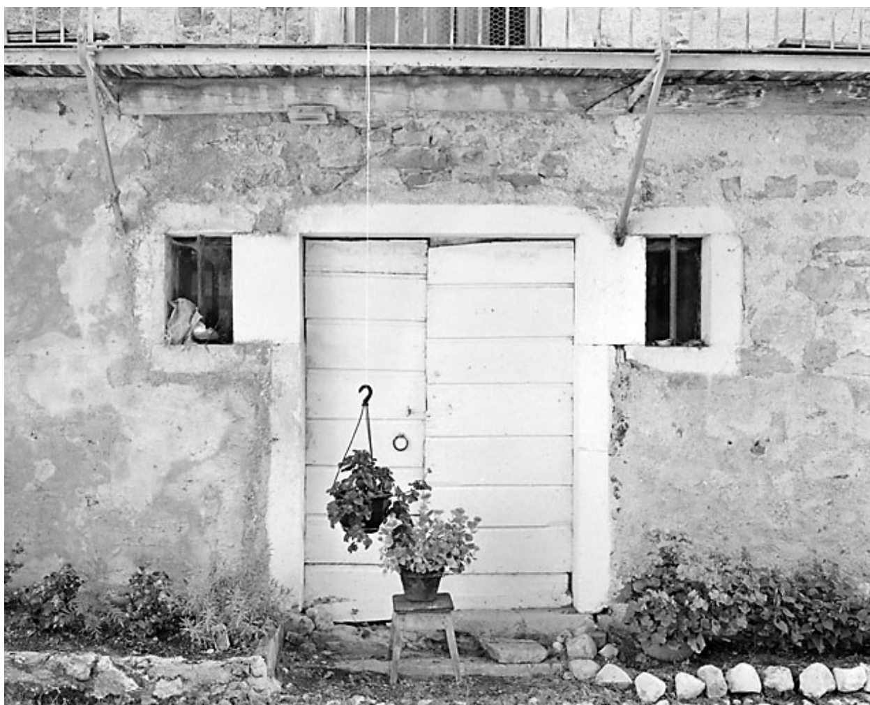
Baies d'un bûcher.
