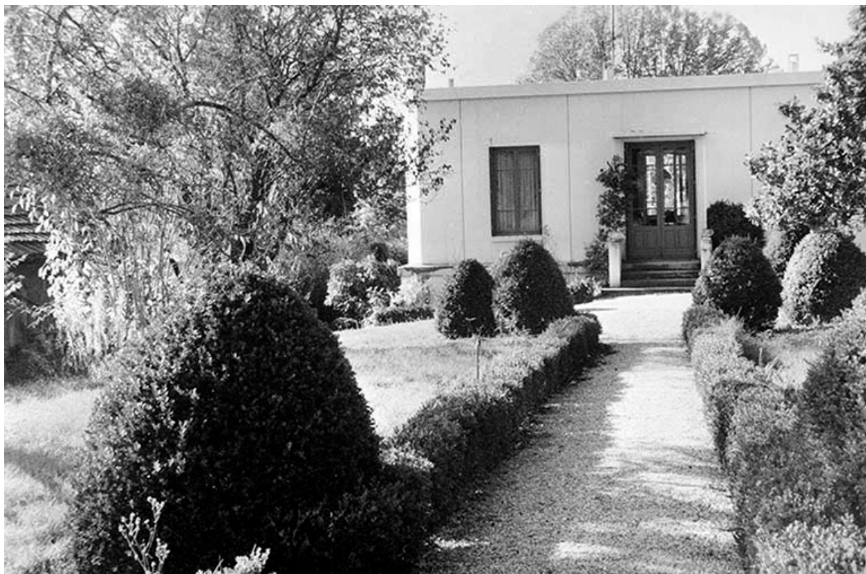
Façade postérieure avant restauration, novembre 1990.
