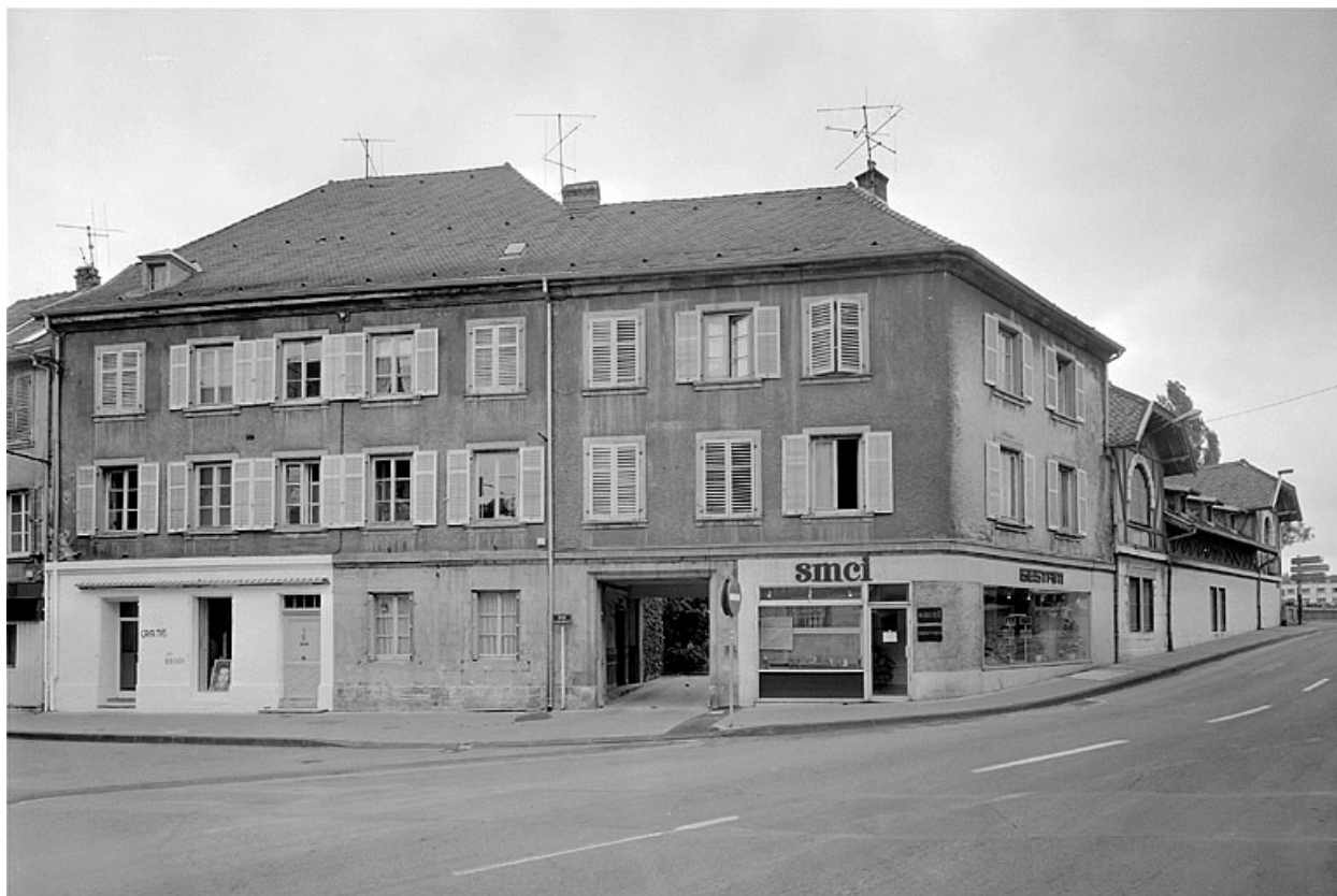
Vue d'ensemble des façades sur rue.
