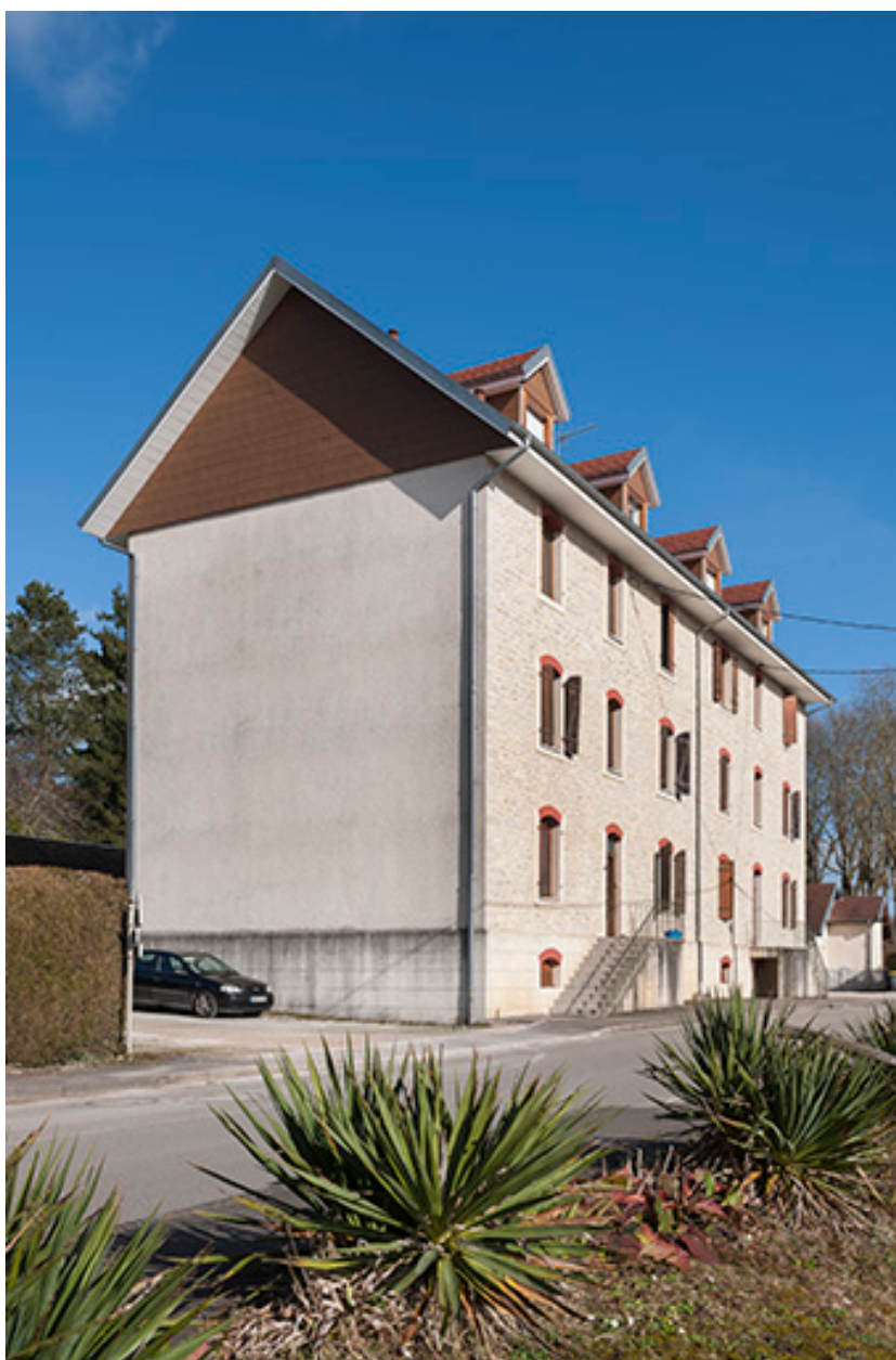
Immeuble de logements. Vue d'ensemble.
