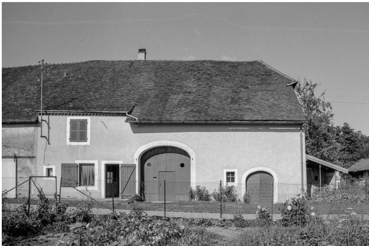
Arlay : ferme située au lieudit Chaze.
