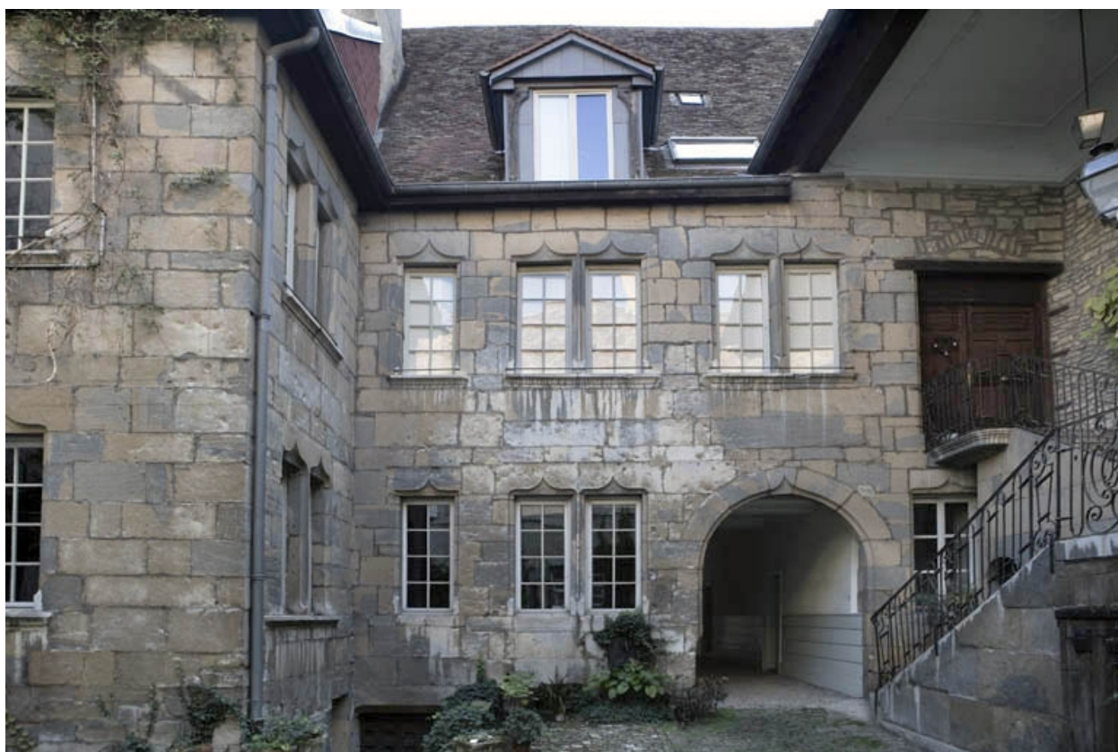
Façade postérieure du logis, de face.
