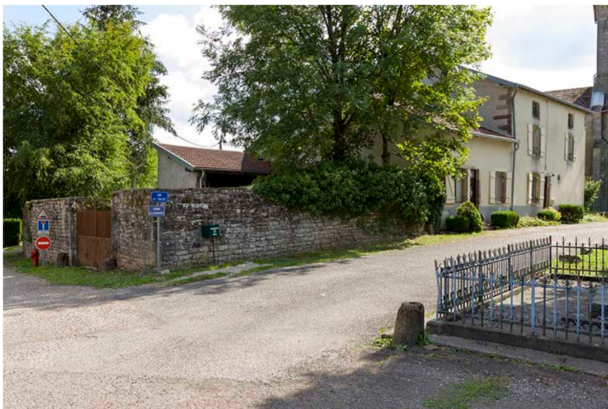
Vue d'ensemble depuis la Grande rue.
