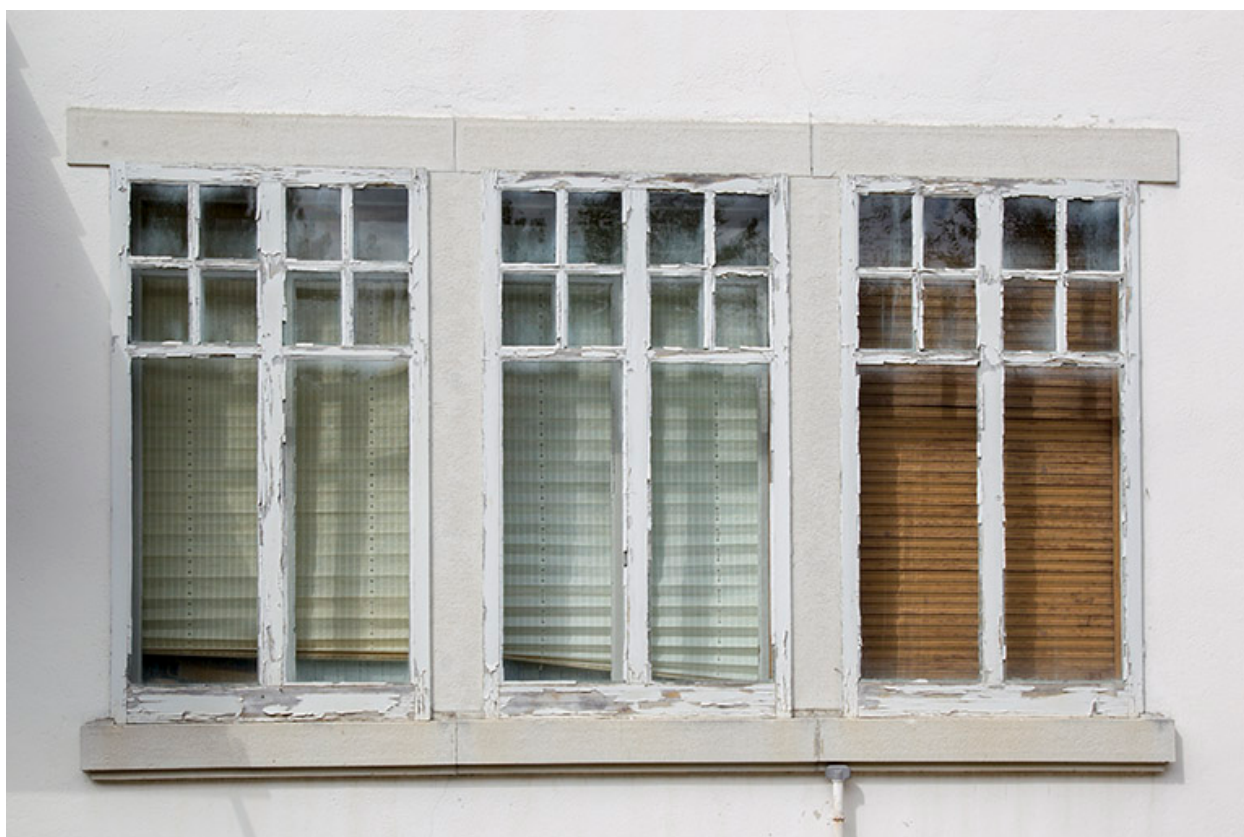
Façade latérale droite : fenêtres multiples.
