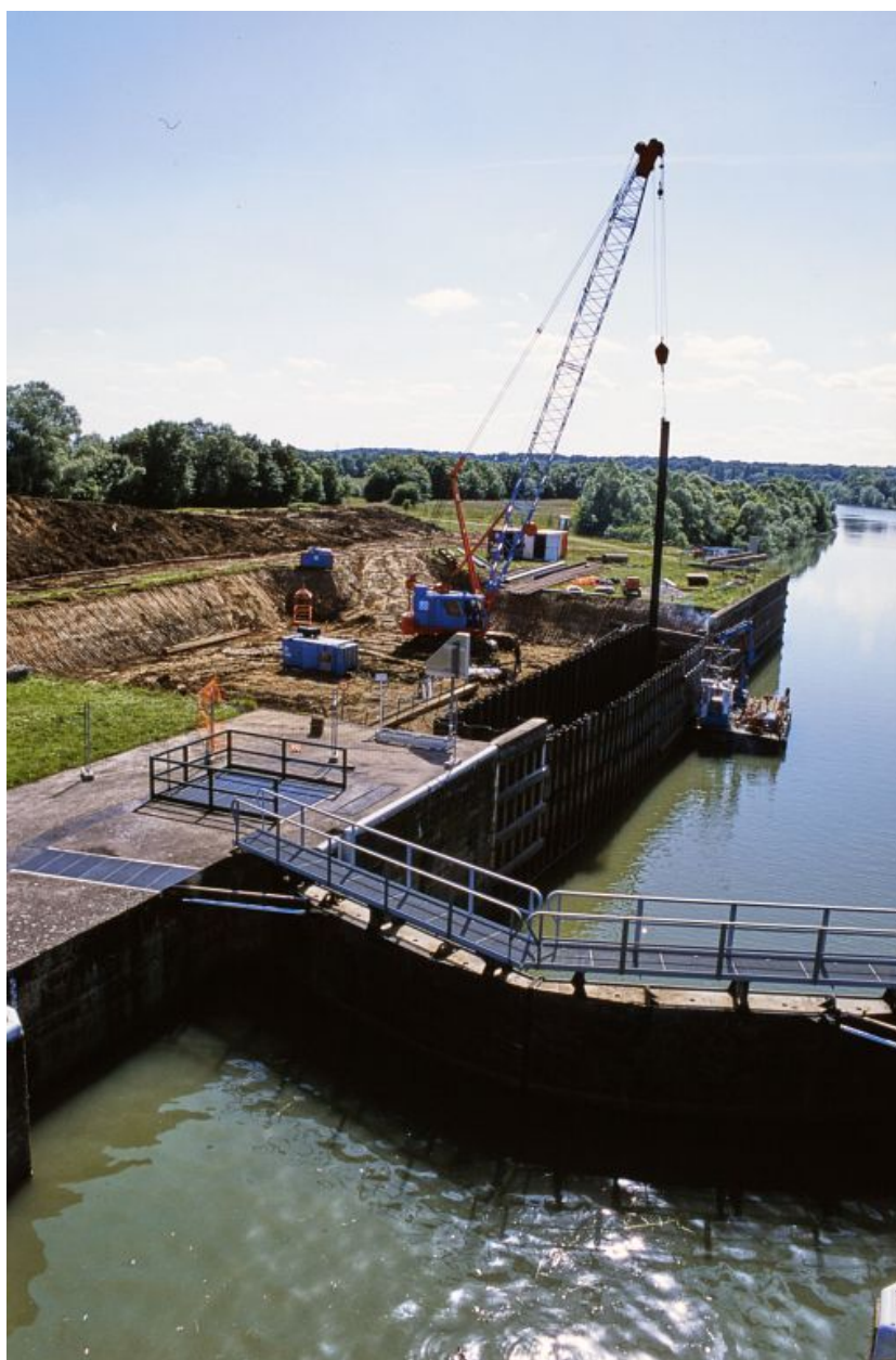
Portes avec passerelle.
