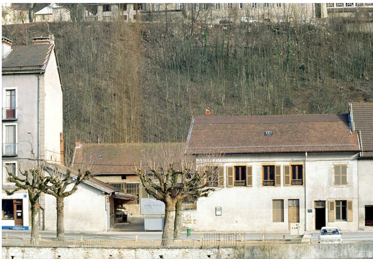
Entrée de l'usine.
