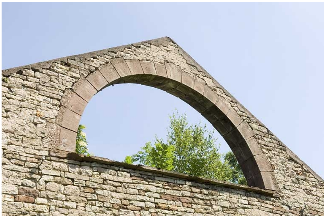
Atelier du laminier. Baie du pignon ouest.
