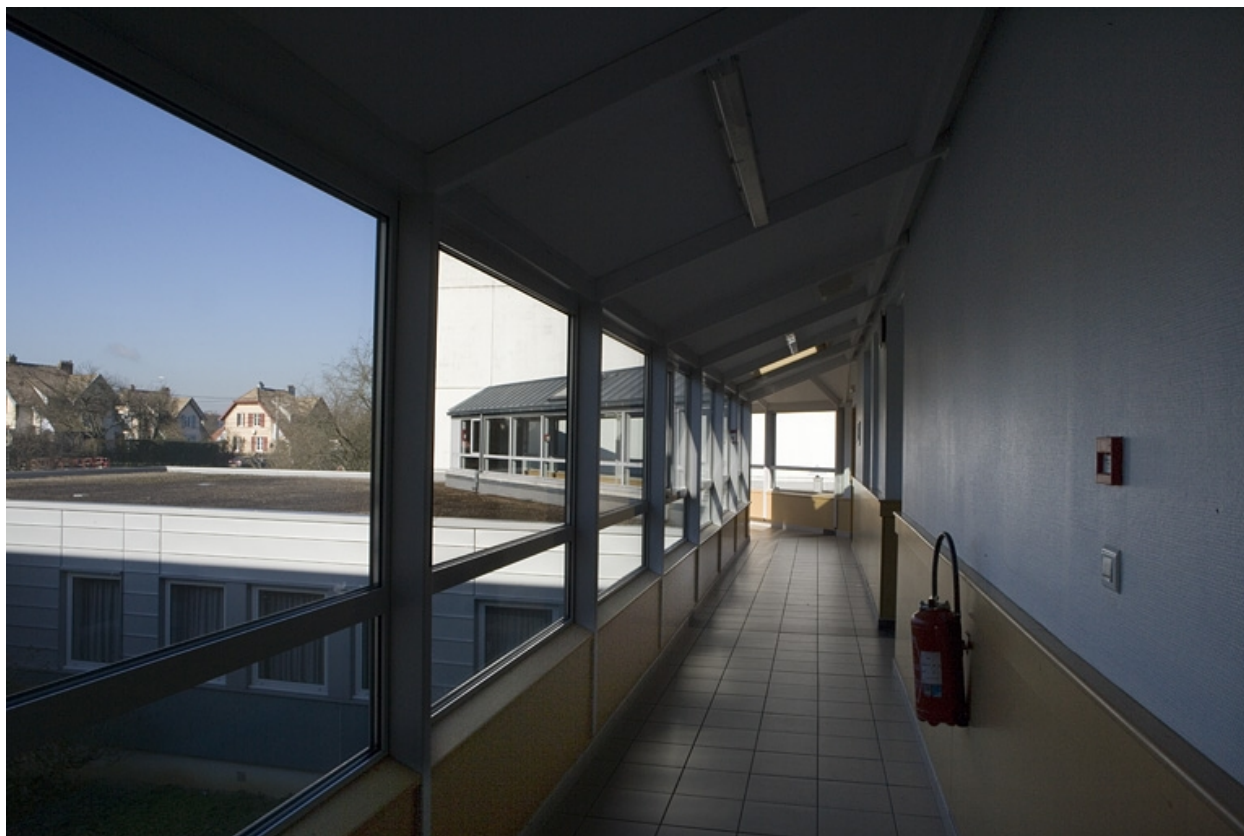
Bâtiment A. Vue de la passerelle.
