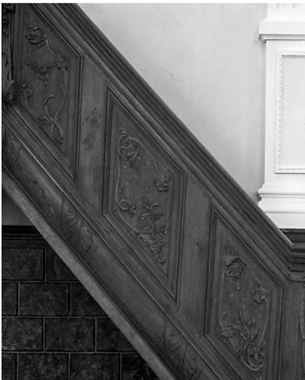
Détail de la rampe.
