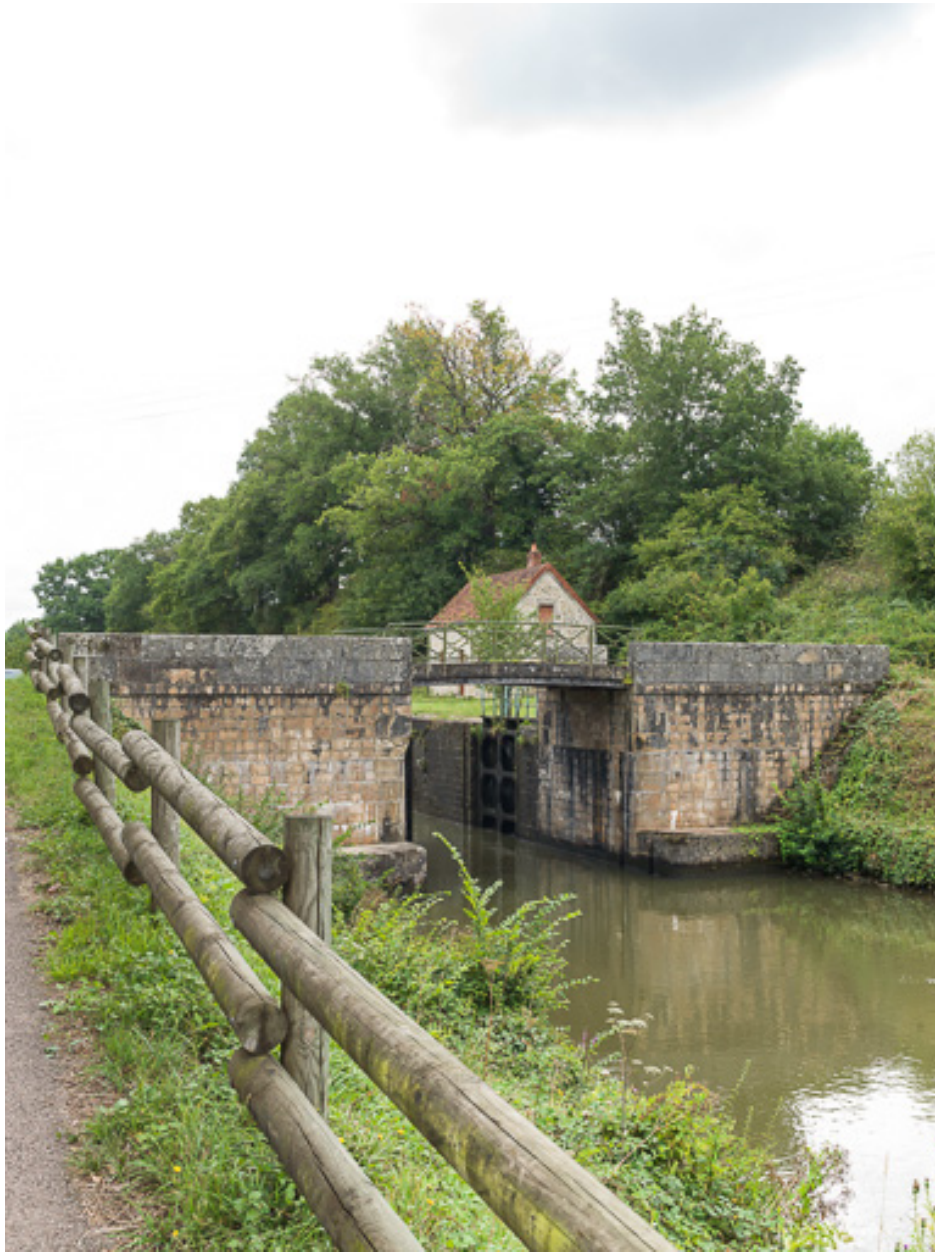
Vue d'ensemble du pont.
