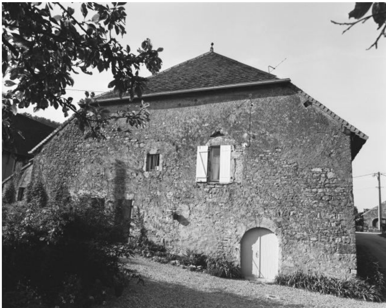
Façade latérale gauche.
