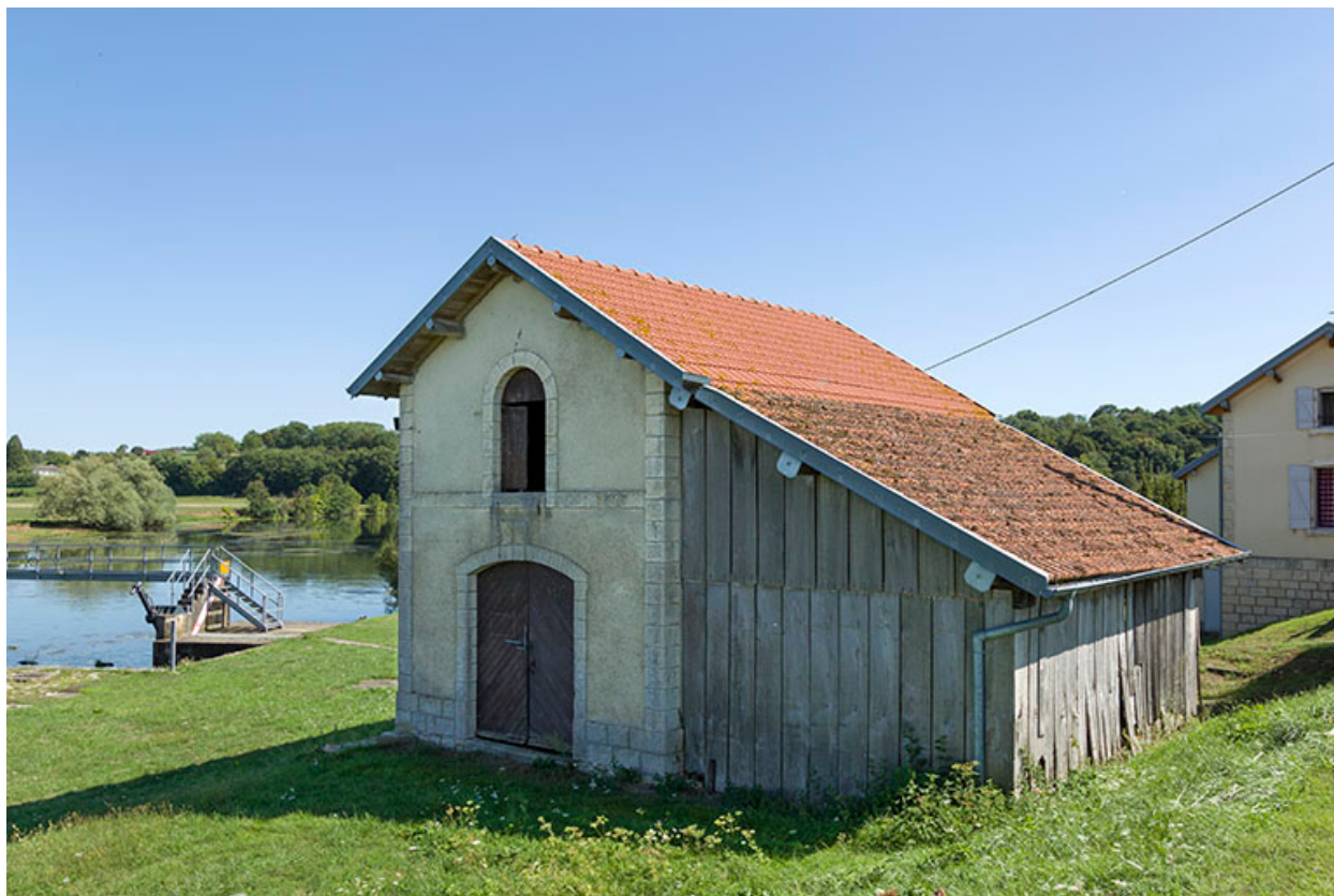
Magasin à aiguilles du barrage.
